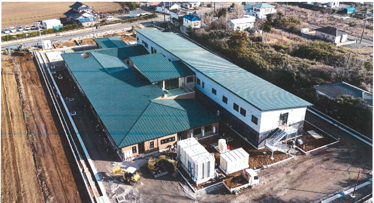
(新園舎建設中) 令和8年度5月～6月開園予定。写真は、令和8年1月6日現在。
